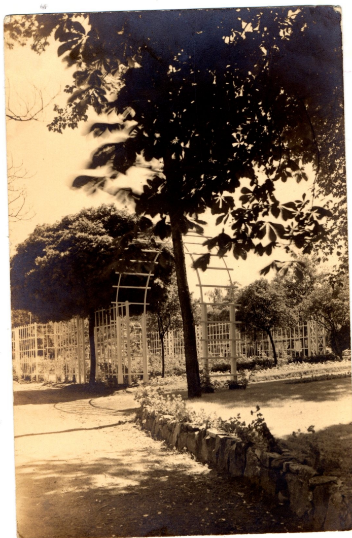
Ilustracja 5: Widok na pergolę od strony północno-zachodniej
