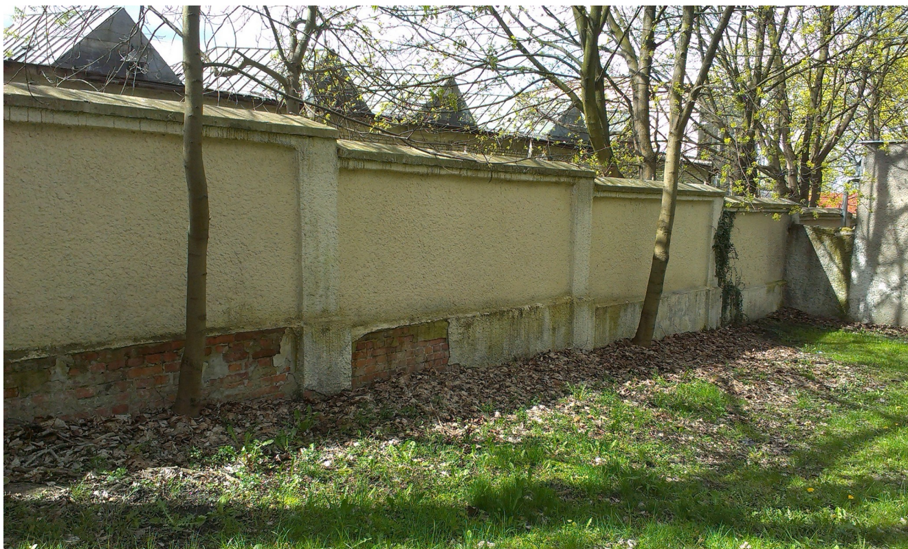
Ilustracja 4: Istniejące ogrodzenie od strony zachodniej - lokalizacja odtwarzanej bramy
