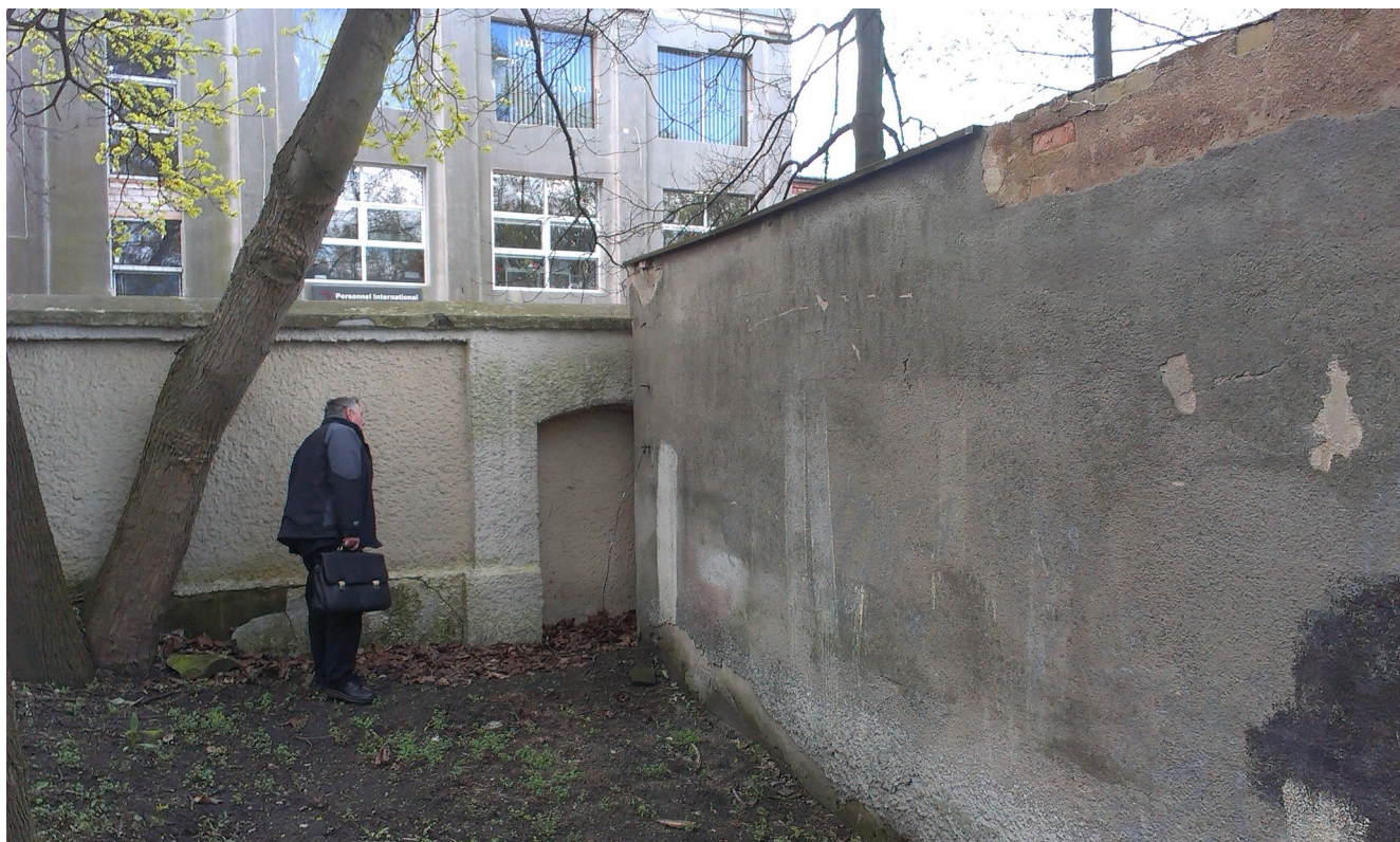
Ilustracja 2: Istniejące ogrodzenie od strony zachodniej - widoczne miejsce po furtce
