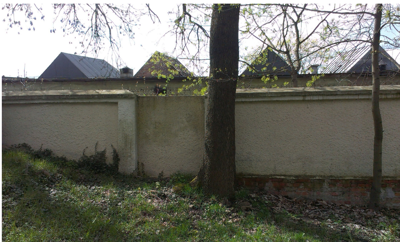
Ilustracja 3: Istniejące ogrodzenie od strony zachodniej - widoczne miejsce po furtce
